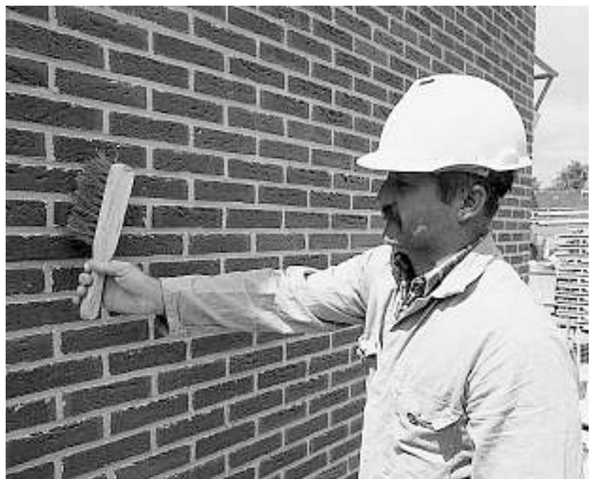
Het schoonborstelen van de gevel zonder gebruik van chemicaliën.
