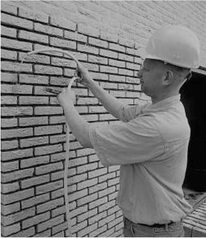
Het verwijderen van cementsluiser met water.
