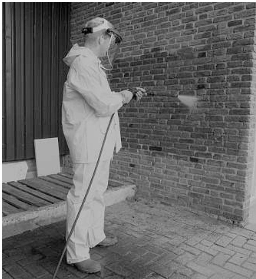
Het met chemicaliën schoonmaken van een gevel.
