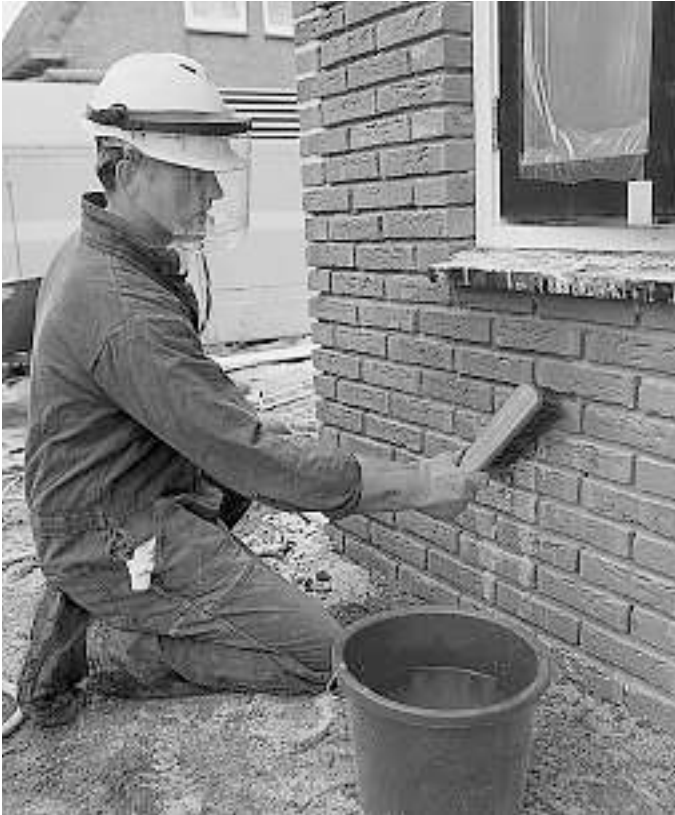
Het schoonborstelen van een gevel met zoutzuur.
