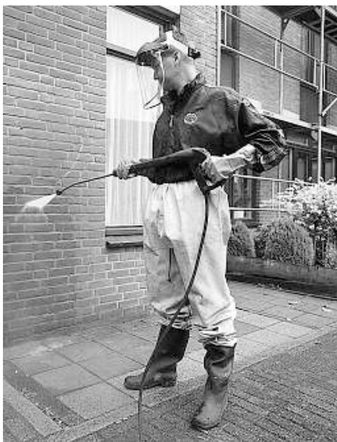
Het reinigen door middel van stralen met water.
