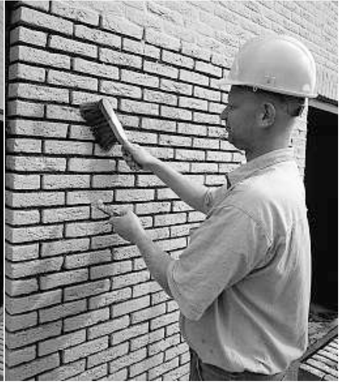
Het schoonborstelen van de gevel.
